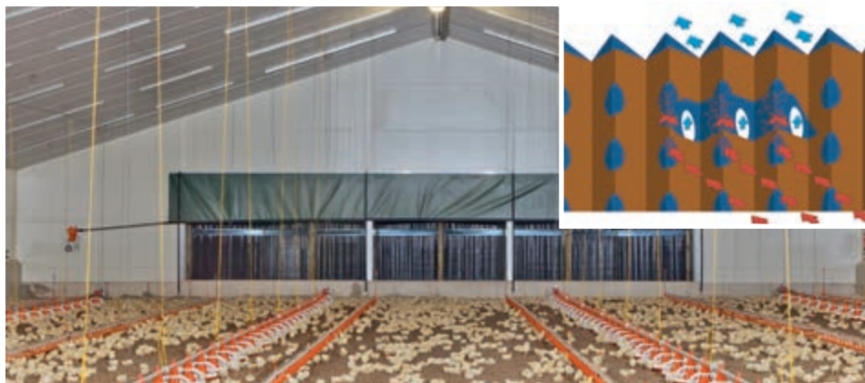
A StuffNix porszűrő alkalmazása egy baromfi istállóban – a minősített mérések alapján 70%-ig terjedő össz. porleválasztás és 32%-os finompor leválasztás érhető el.
